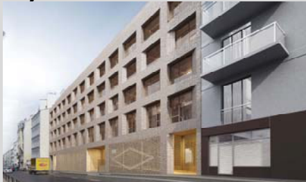
Façade depuis la rue Pelleport
